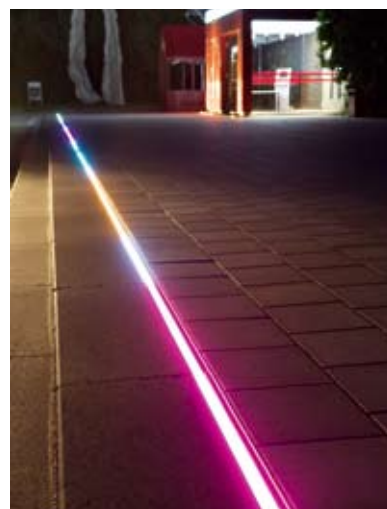
Liniedræn diskret sammenbygget med designlys
