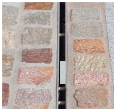
Samling ved brug af Brickslot klips
