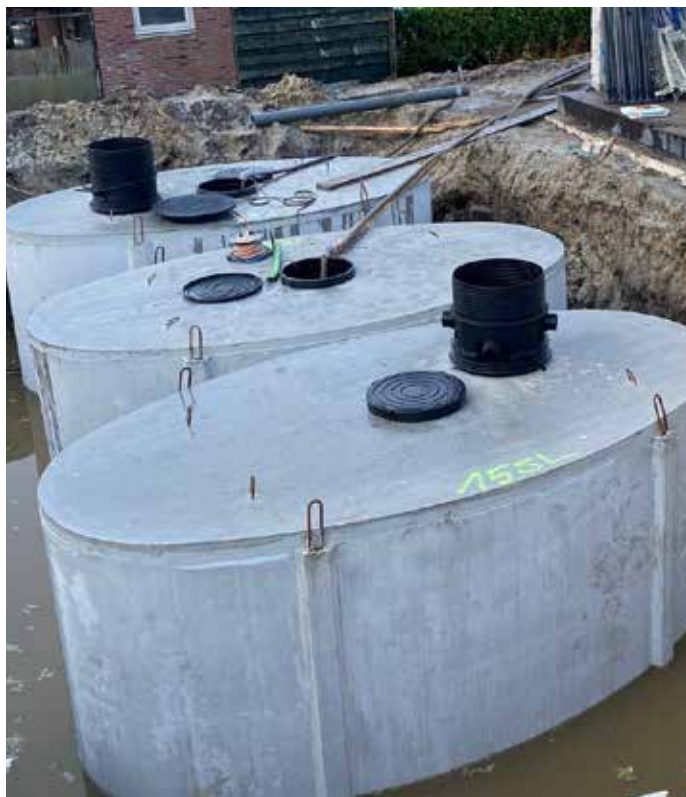
Foto 3: Varitank Filterschacht op geschakelde betonnen warmteputten.
